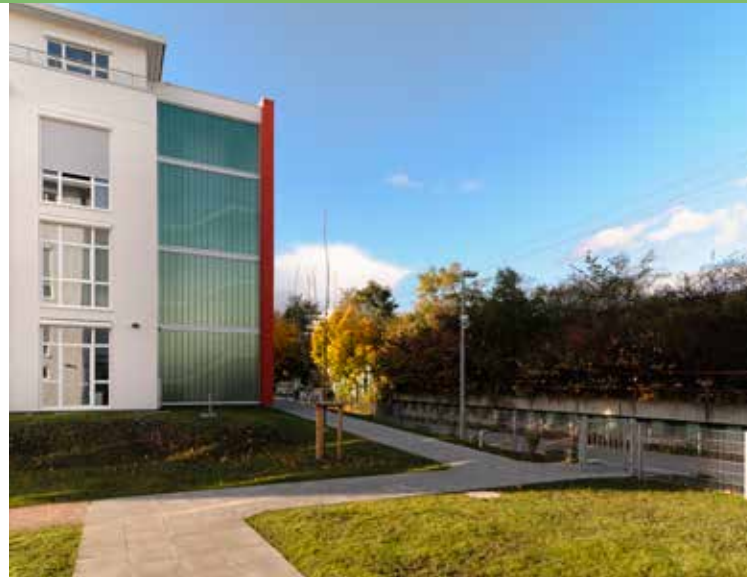
Ein Teil des Gartengeländes
